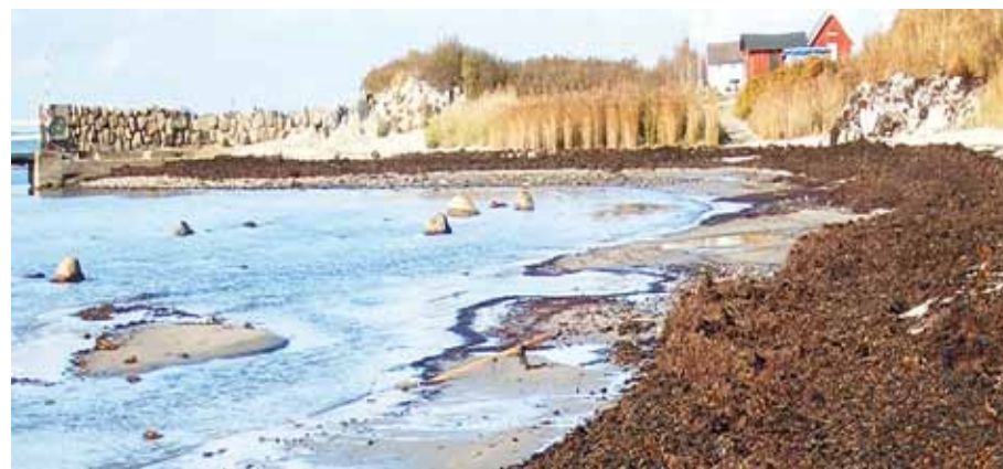
Tångbarriär vid norra bryggan, som mildrar stranderosionen.
