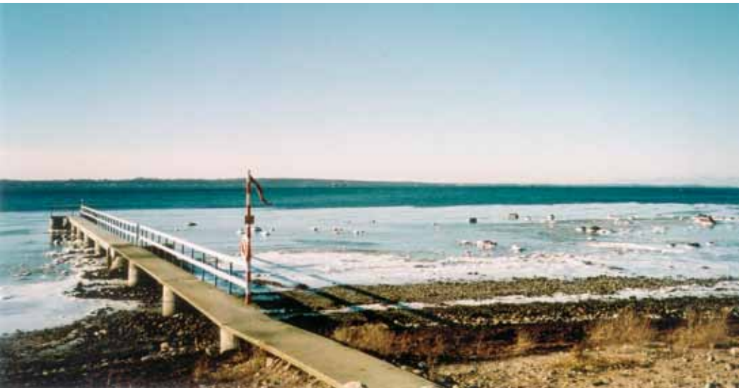
En vacker vinterbild på nya bryggan år 2000. Stormen tog vår gamla brygga. Kommunen har på ett förtjänstfullt sätt byggt om bryggan med kraftiga betong-block och nya räcken. Nu hoppas vi bryggan skall klara alla nya stormar.
